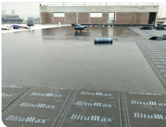
Thi công màng tự dính
