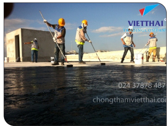
Thi công lăn lớp lót
