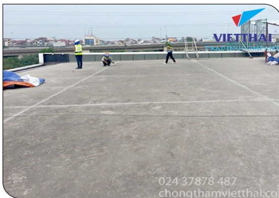
Chuẩn bị bề mặt
