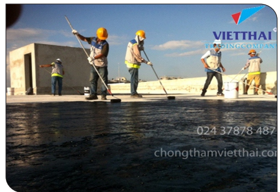
Thi công lăn lớp lót
