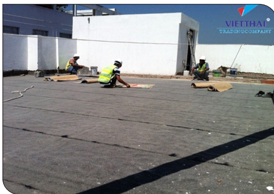
Thi công màng tự dính
