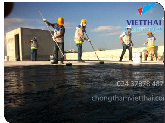
Thi công lăn lớp lót
