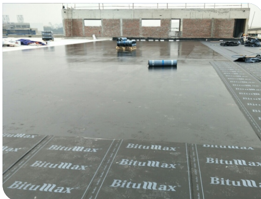
Thi công màng tự dính
