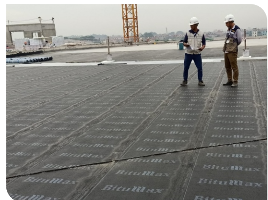
Bề mặt hoàn thiện
