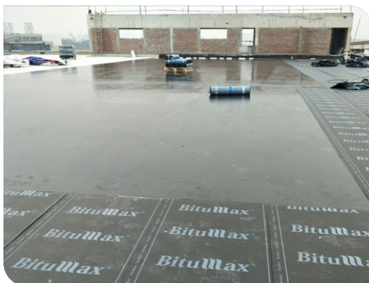
Thi công màng tự dính
