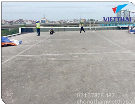
Chuẩn bị bề mặt
