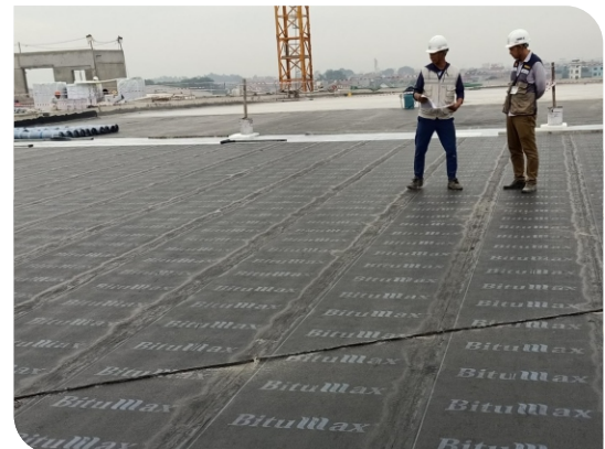
Bề mặt hoàn thiện
