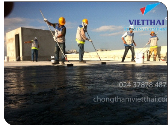
Thi công lăn lớp lót
