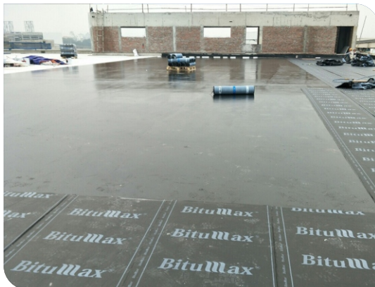
Thi công màng tự dính
