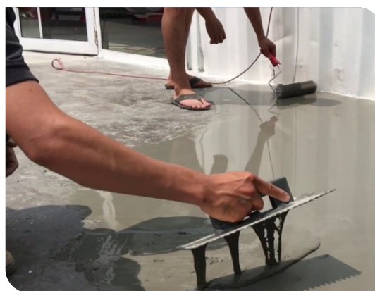
Thi công cán hồ dầu
