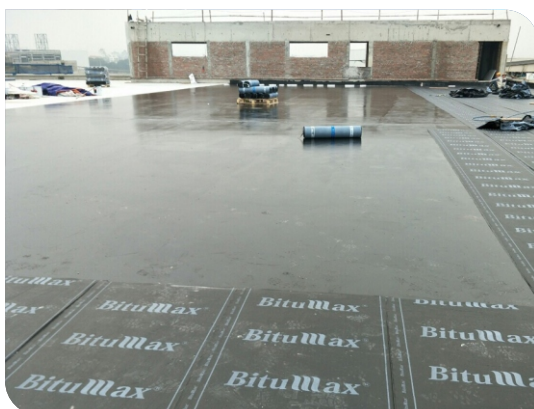
Thi công màng tự dính
