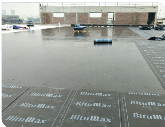
Thi công màng tự dính
