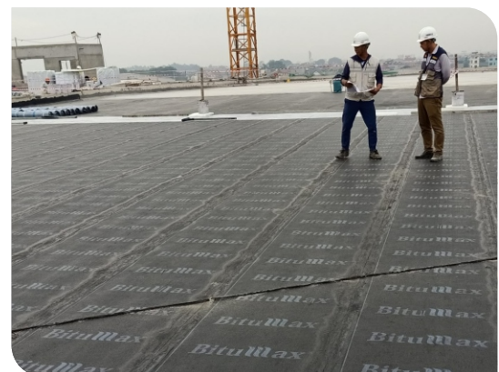
Bề mặt hoàn thiện
