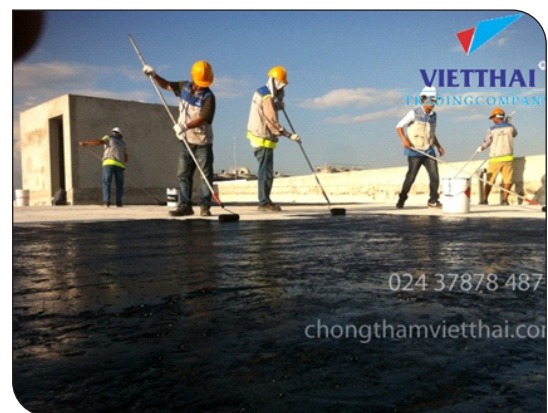
Thi công lăn lớp lót
