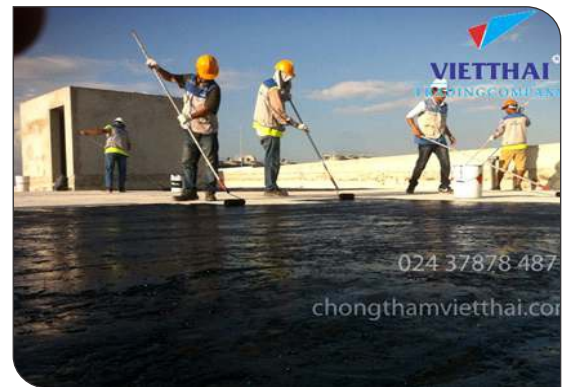
Thi công lăn lớp lót
