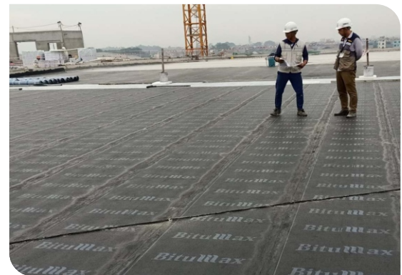
Bề mặt hoàn thiện
