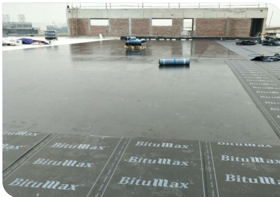
Thi công màng tự dính
