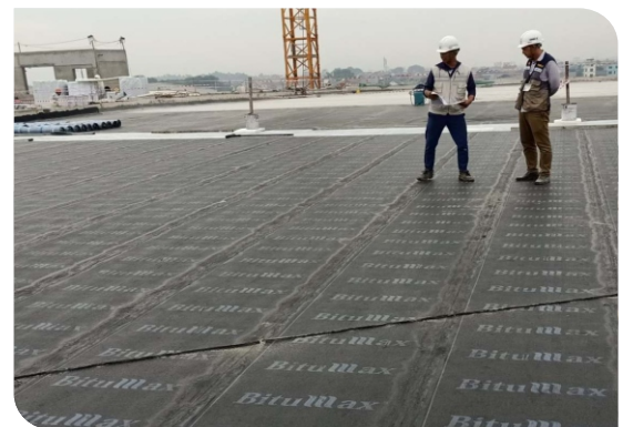
Bề mặt hoàn thiện
