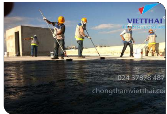
Thi công lăn lớp lót
