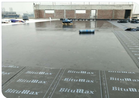
Thi công màng tự dính
