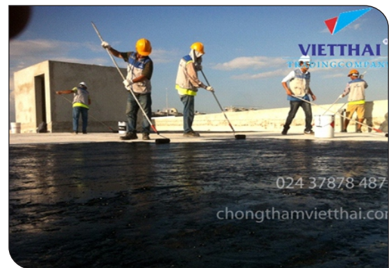
Thi công lăn lớp lót
