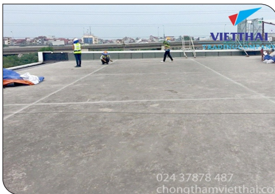
Chuẩn bị bề mặt
