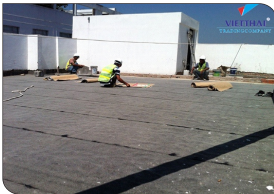
Thi công màng tự dính
