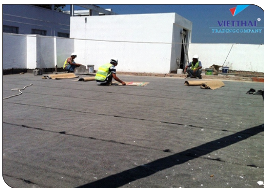
Thi công màng tự dính
