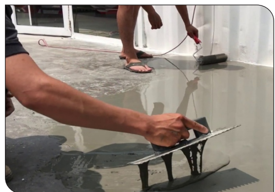
Thi công cán hồ dầu
