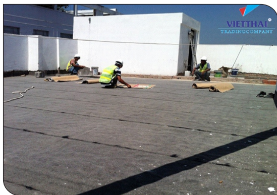
Thi công màng tự dính
