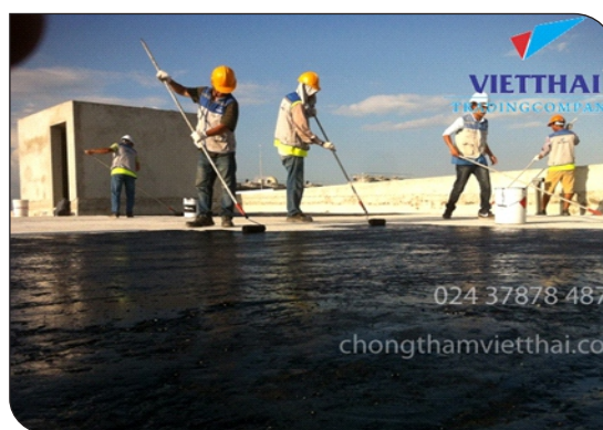
Thi công lăn lớp lót
