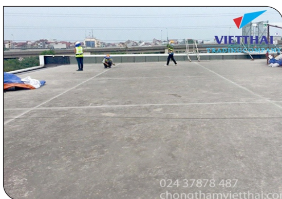
Chuẩn bị bề mặt
