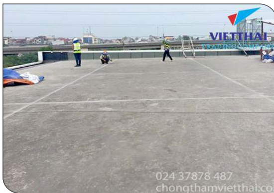
Chuẩn bị bề mặt
