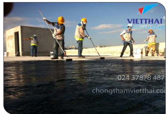
Thi công lăn lớp lót
