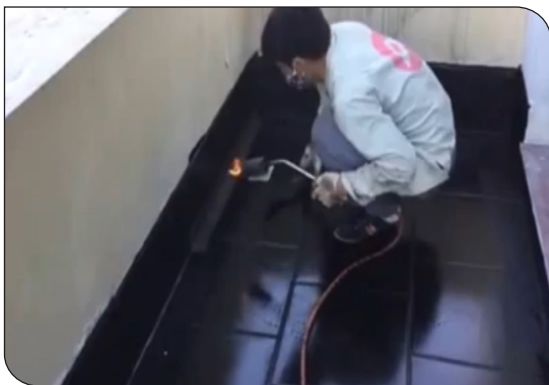
Xử lý góc chân tường
