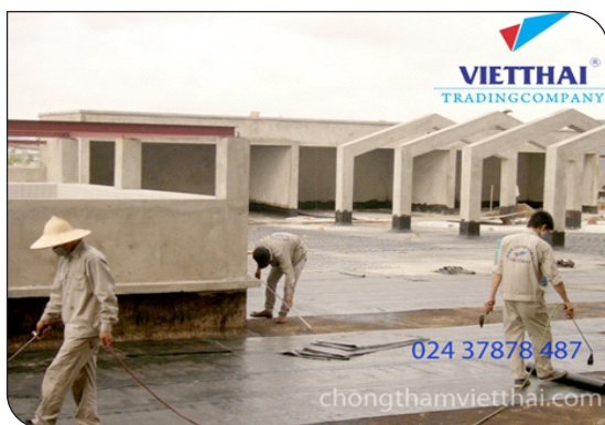
Thi công màng khô nóng
