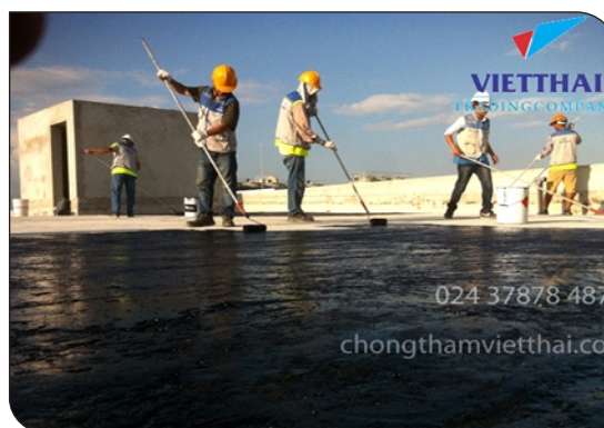
Thi công lăn lớp lót
