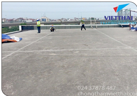
Chuẩn bị bề mặt
