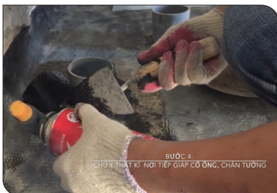
Xử lý cổ ống thoát nước
