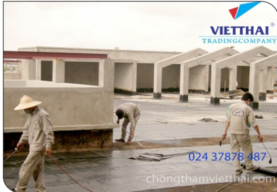
Thi công màng khô nóng
