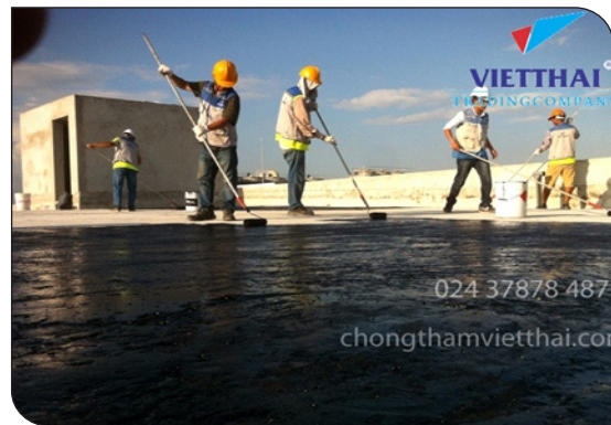
Thi công lăn lớp lót
