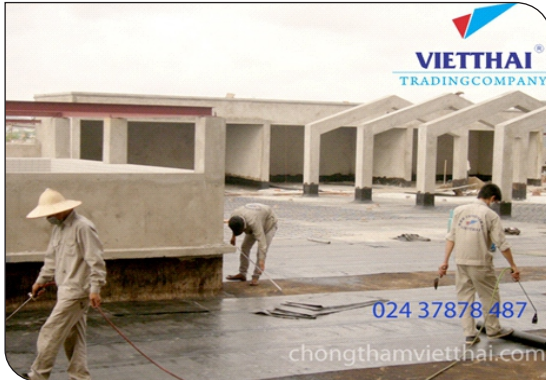
Thi công màng khô nóng
