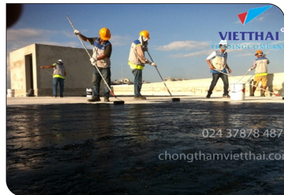
Thi công lăn lớp lót
